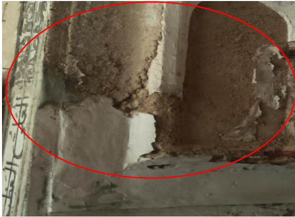
Fig 28: Cracks on Mehrab wall
